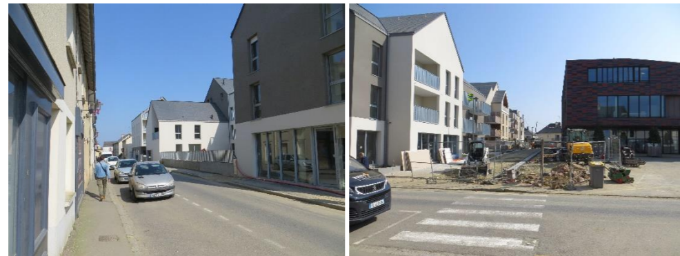
Figure 9 : ZAC Centre-Ouest – Renouvellement urbain – La Mairie / Rue du Centre (Source : ARCHIPOLE, LA PLAGÉ – Avril 2022)
